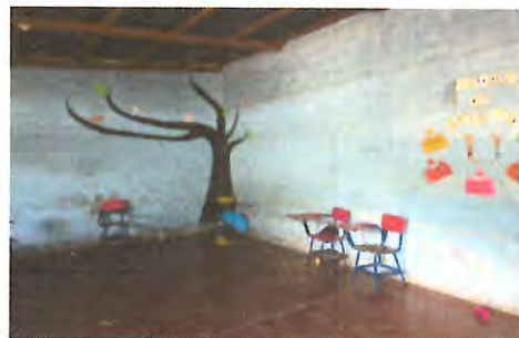
Foto 2: PINTURA EN MUROS INTERIOR Y EXTERIOR
