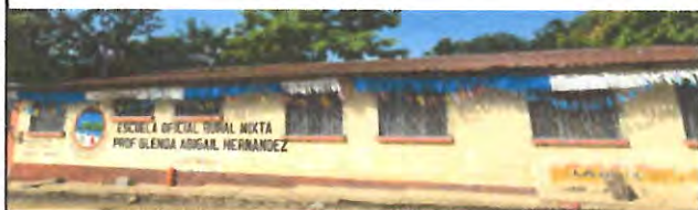
Foto 5: CUBIERTA DE LAMINA
